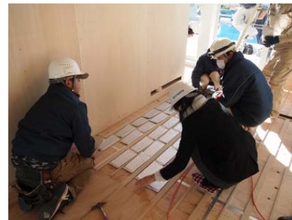
床下に封入した潜熱蓄熱体のパック
