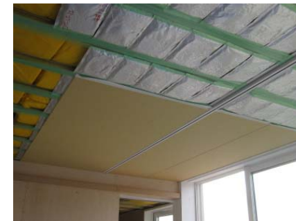
天井にもアルミパックに封入された潜熱蓄熱体を設置
