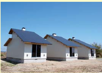
地球のたまご敷地内の3棟の実験棟。合計1000を超える温度センサや熱流計による詳細計測を実施中。
