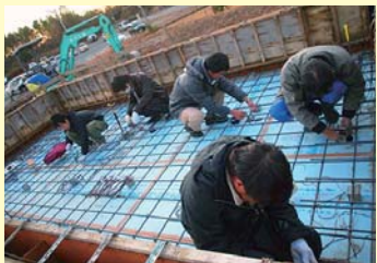
前研究室のメンバーとOMソーラー(株)社員による、熱電対の組み込み作業。
