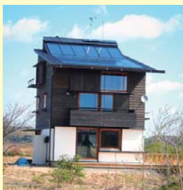
同敷地内の住宅型実験棟。太陽熱+太陽光利用の「OMクワトロソーラー」を採用し、住まいに近い環境下で詳細計測を実施中。
