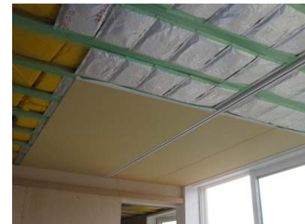
天井にもアルミパックに封入された蓄熱蓄熱体を設置
