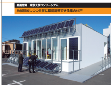
都市型集合住宅の構造、様々な住戸が自立し自立する居住性を実現。高層ビルと一体にして建設できるエネルギー自立型に挑戦し、フルスケールで高層集合住宅を実現するためのアイデアを練り込んだ。住戸の中に、東と西を貫くリフトを設置。天井と床の隙間、壁の隙間を埋めて空気滞留を防ぎ、自然の風を効率的に導入する。空調システムは、冷暖房を効率的に導入する。チームをまとめた東京大学工学部材料建築学専攻教授佐藤隆之助は、「環境の良さを活用して、手頃な上での集約化を実現された」と話す。
