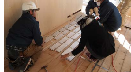
床下に封入した蓄熱蓄熱体のパック
